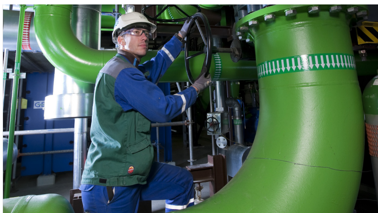
Abbildung 2: Wartungsarbeiten in einem Fortum-Kraftwerk
